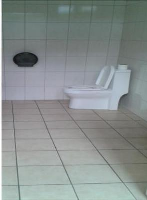
**2.** Se instalaron en el segundo piso servicios sanitarios de doble descarga y para los servicios sanitarios convencionales se les reguló la boya para que dispensarán una cantidad de agua previamente establecida, ambos sistemas colaboran con el ahorro de agua en cada una de las descargas.
