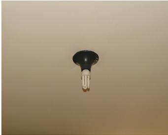
2. Se cambió toda la iluminación del edificio pasando de los bombillos incandescentes por bombillos fluorescentes que favorecen el ahorro de electricidad, este tipo de iluminaria tiene una mayor vida útil, pues consumen menos energía eléctrica y producen la misma cantidad de luz que los bombillos convencionales, además el tipo de luz blanca que emiten es más estética que la convencional luz amarilla.
